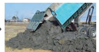
④ 改良土を仮置き・養生
