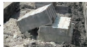
② 繊維質泥土改良材の投入・攪拌
