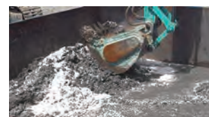
③ 固化材の投入・攪拌
